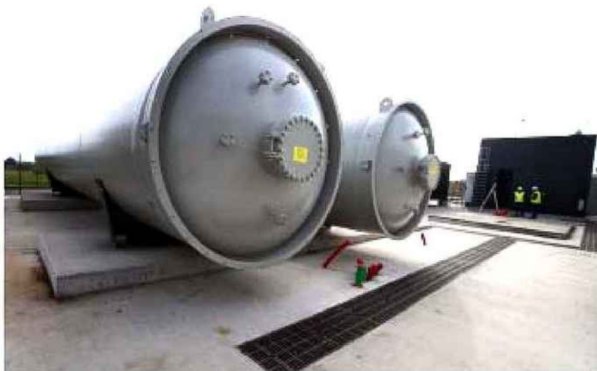
Deux cuves de stockage sont arrivées sur site mardi, un emplacement pour une troisième est prévu.
